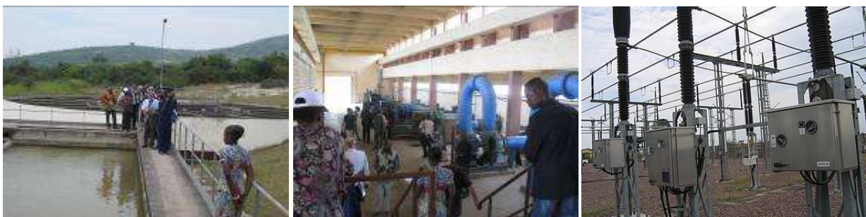
▲ Station de pompage de Djiri
